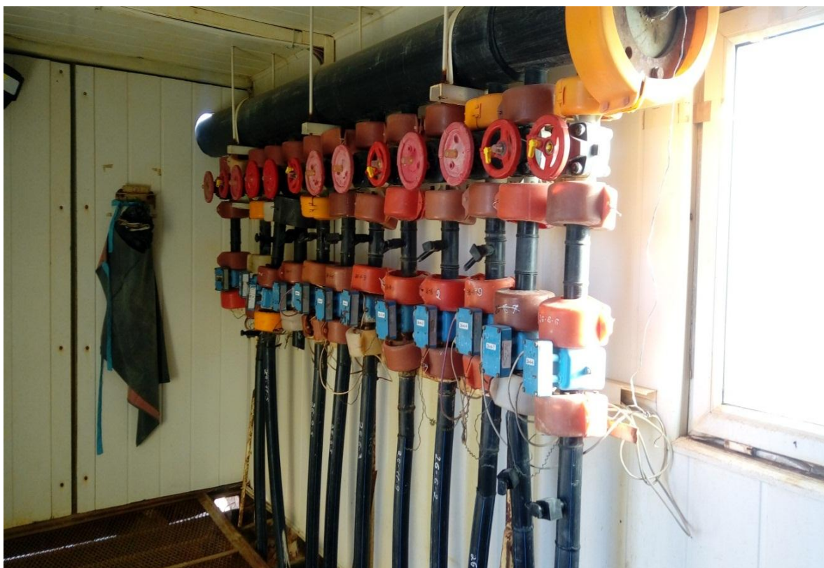
10(а) Сурет - Сорғыту(откачка) ұңғымаларының ТУРР- ға жалғануы.
